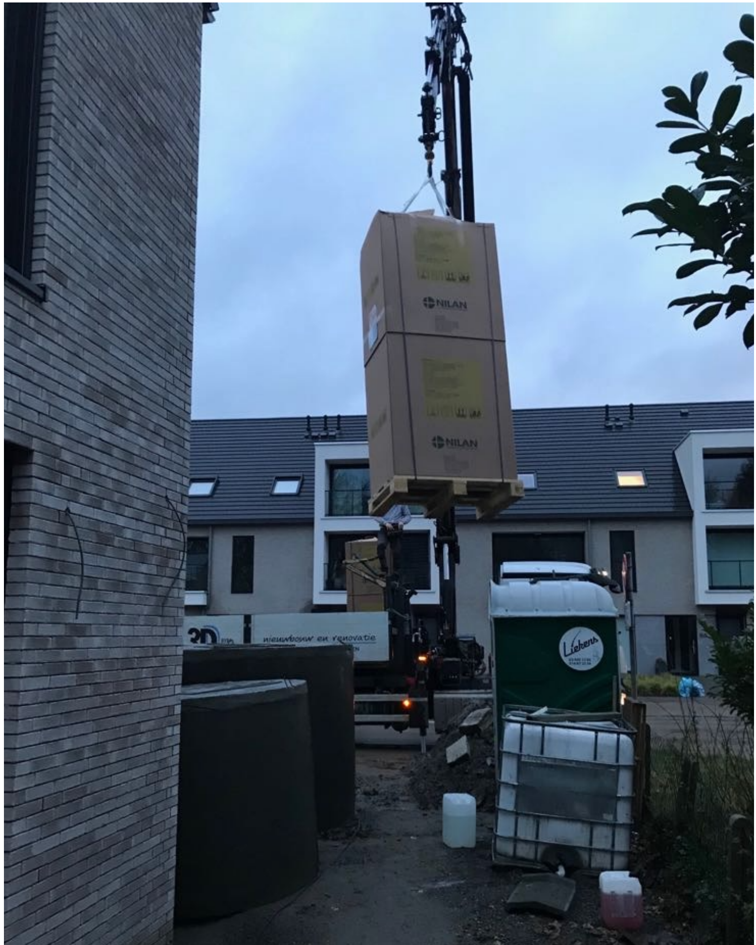
Alle Compact P systemen zijn standaard voorzien van hijsbanden voor het eenvoudig plaatsen van het toestel op een verdieping.
